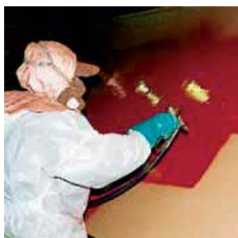
Technika Hot Job s ohřevem NH
